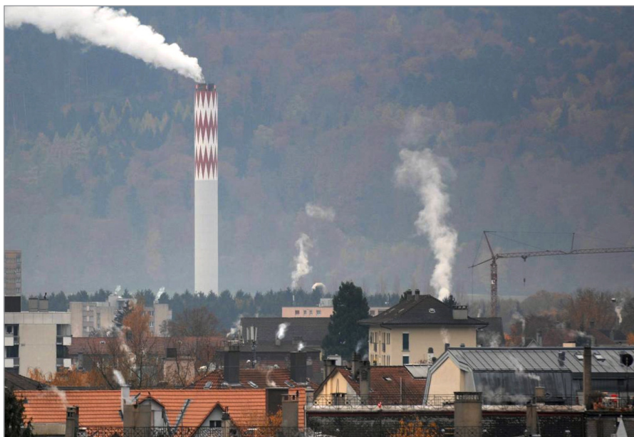
Il 60% circa delle emissioni di monossido di carbonio sono causate dall'uomo. Oltre ai gas dovuti ai trasporti, i sistemi di riscaldamento e la sigaretta sono fonti di questo gas.
